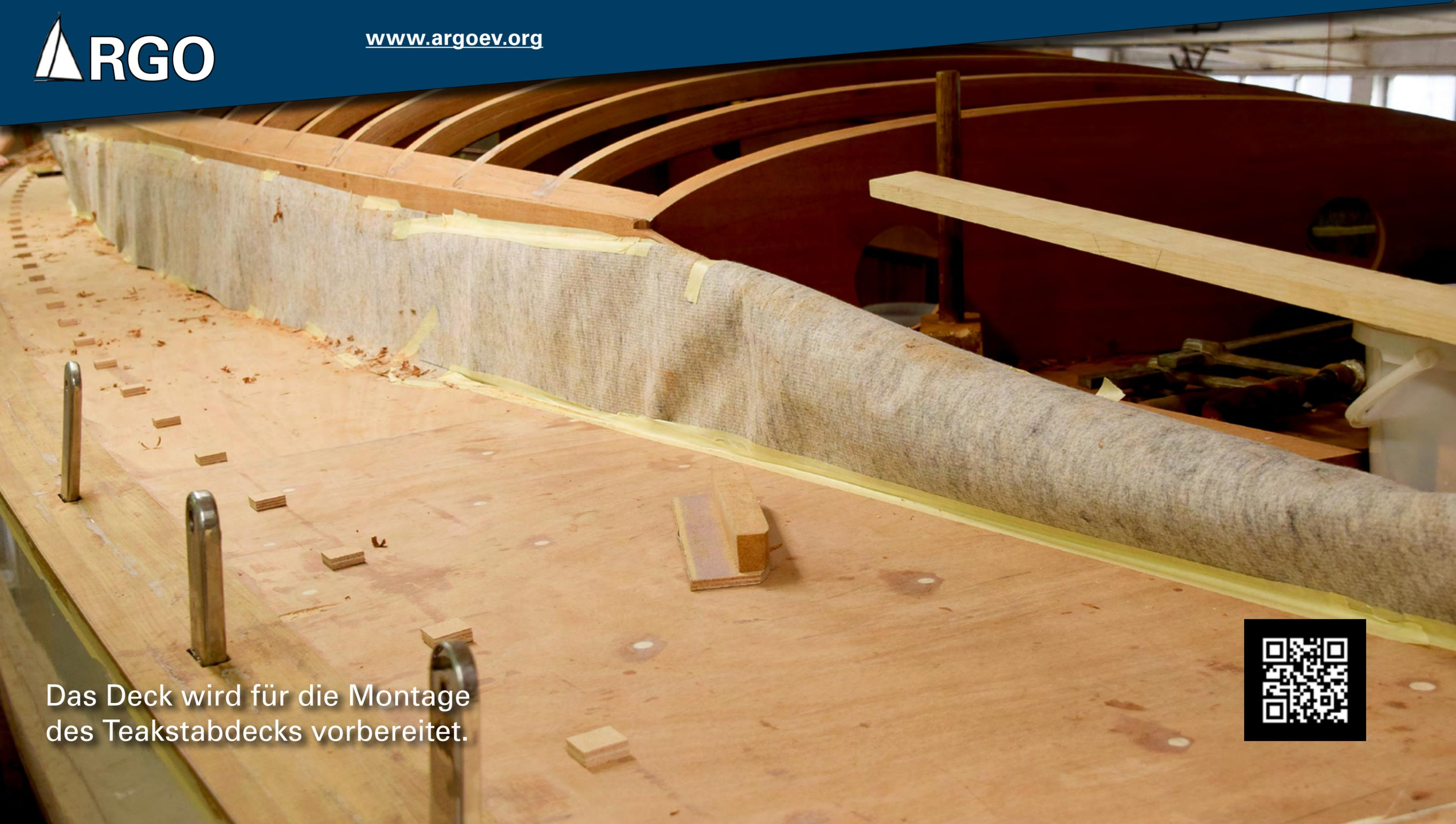
Das Deck wird für die Montage des Teakstabwecks vorbereitet.
