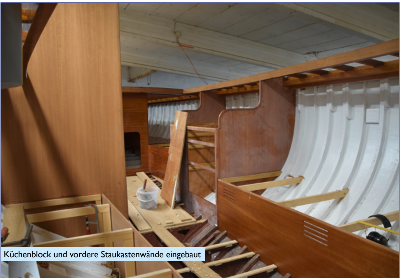
Küchenblock und vordere Staukastenwände eingebaut
