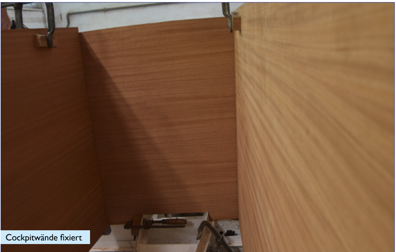
Einbau/Einpassen einer Cockpitwand an der Backbordseite
