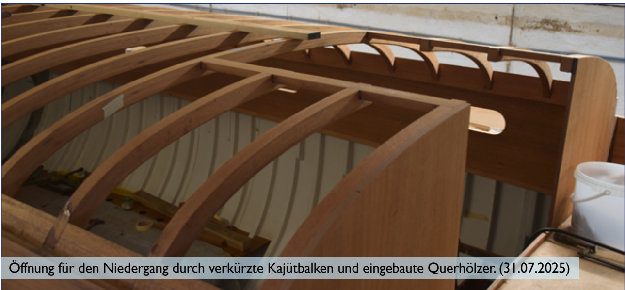
Backbordseite nach dem Glätten der Kajütbalkenträger mit dem Hobel
