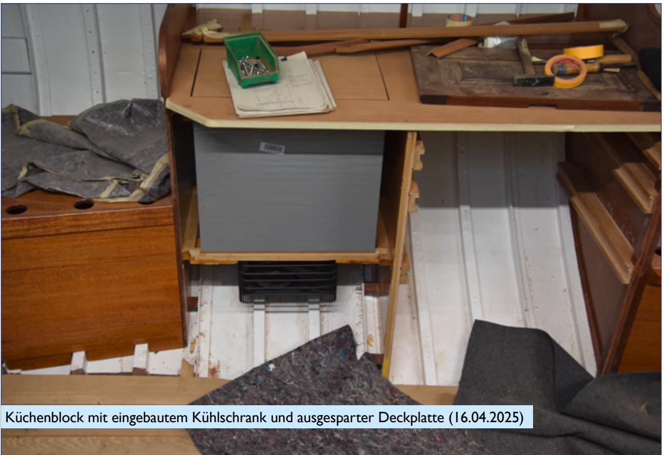
Küchenblock mit bereits eingebauten Schubfächern und Abdeckung für Kühlschrank
