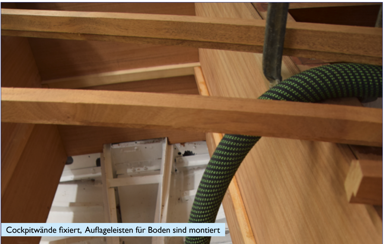
Einbau/Einpassen einer Cockpitwand an der Backbordseite
