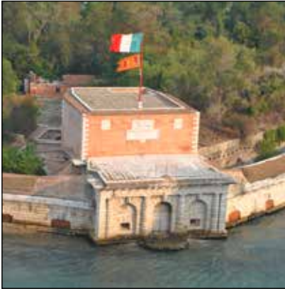
Einfahrtsbastion in den Hafen
