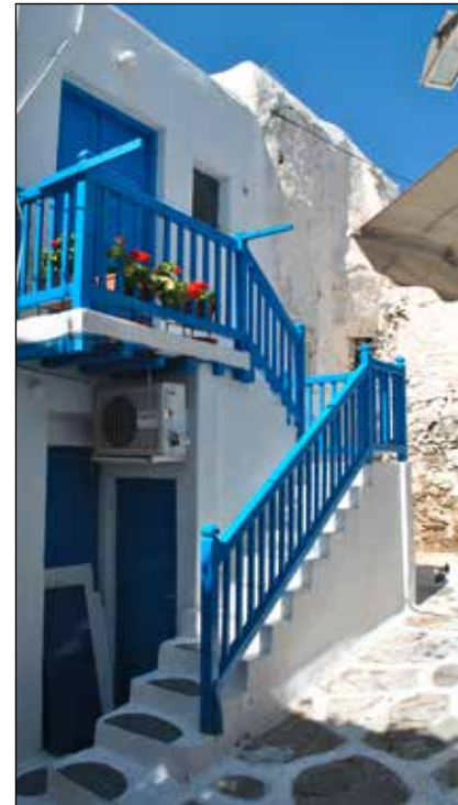
Aufgang zum Etagenhaus
