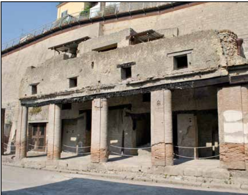
Aufgang zur Oberstadt (nicht weiter ausgegraben)
