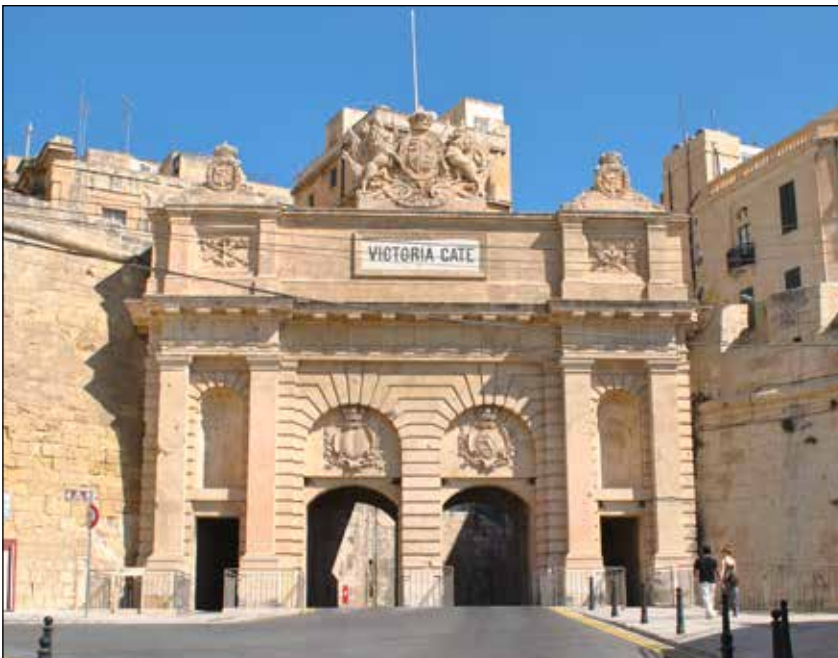
Victoria-Gate – Eingang vom Hafen in die Stadt
