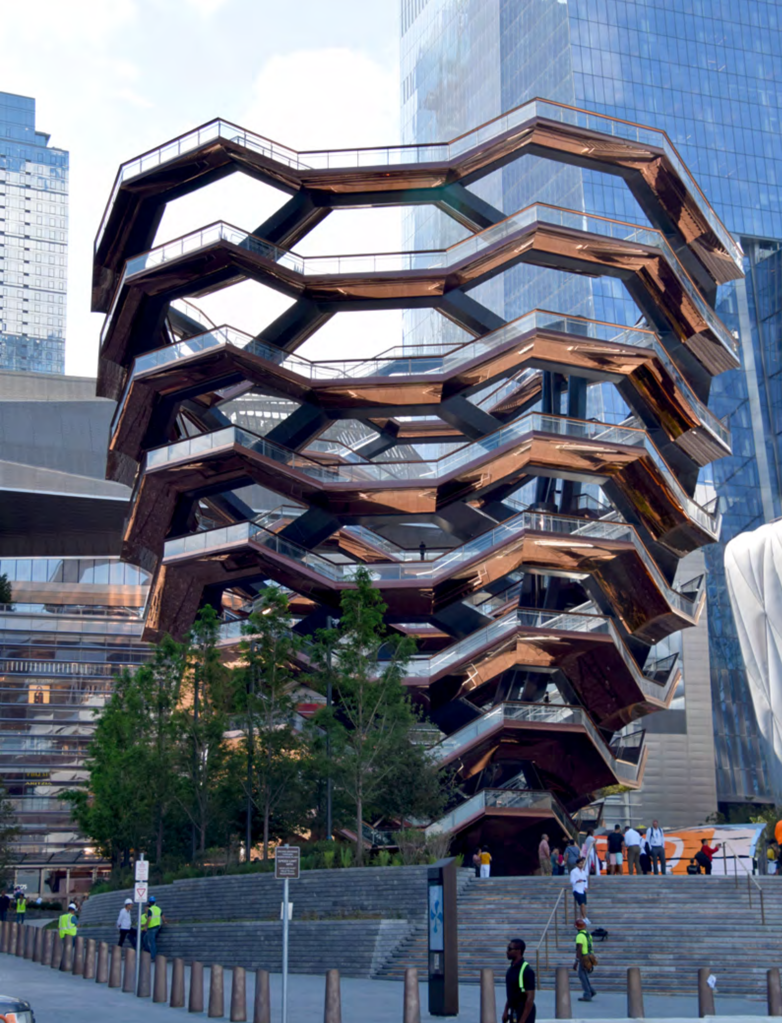
Hudson Yard – Treppenturm „The Vessel“, entworfen vom britischen Architekten Thomas Heatherwick
