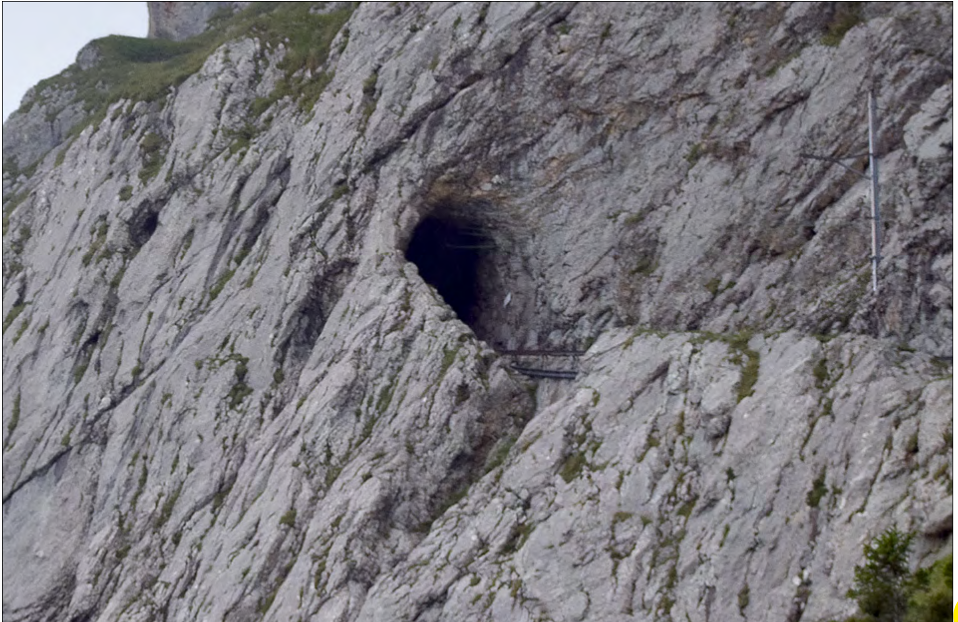
Tunneleinfahrt im Steilbereich mit Oberleitungsmast
