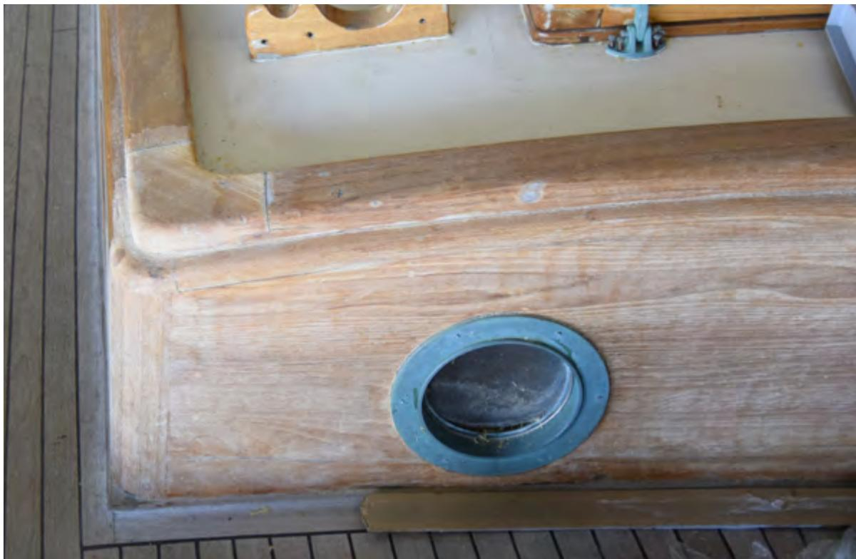
Abgeschliffener Kajütaufbau und Handlauf mit Ausbesserung der Eckrundungen
