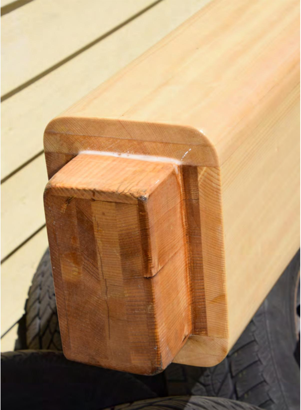
Mastfuß Großmast nach der Holzsanierung und Schlusslackierung
