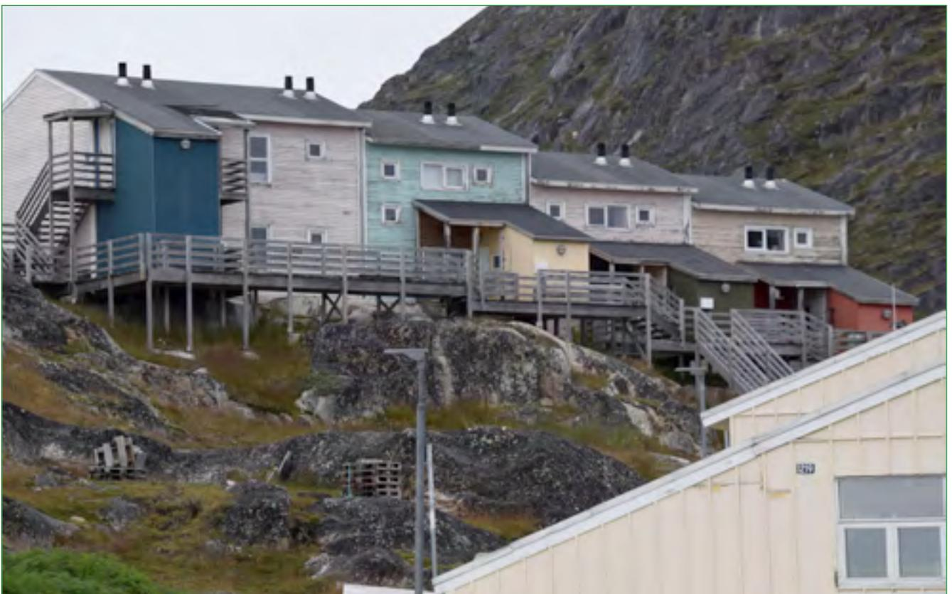
*Unter oder neben den Treppen sind die Leitungen für die Fernwärme immer gut zugänglich verlegt. So können diese bei Bedarf schnell ausgebessert werden.*
