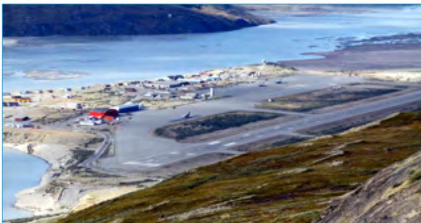
*Kangerlussuaq-Airport mit einer asphaltierte Landebahn mit einer Länge von 2810 m und einer Breite von 60 m. Die Landebahn verfügt über Flächenenteisungseinrichtungen. Der Airport wird 2023/24 renoviert.*
