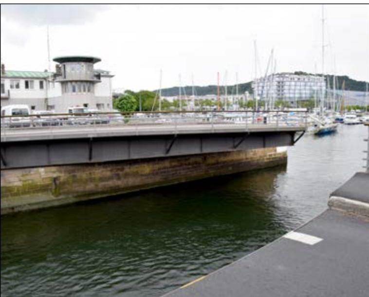
Drehbrücke wird gerade geschlossen
